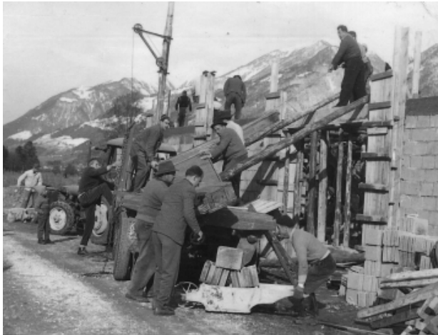
Bau der Turnhalle
